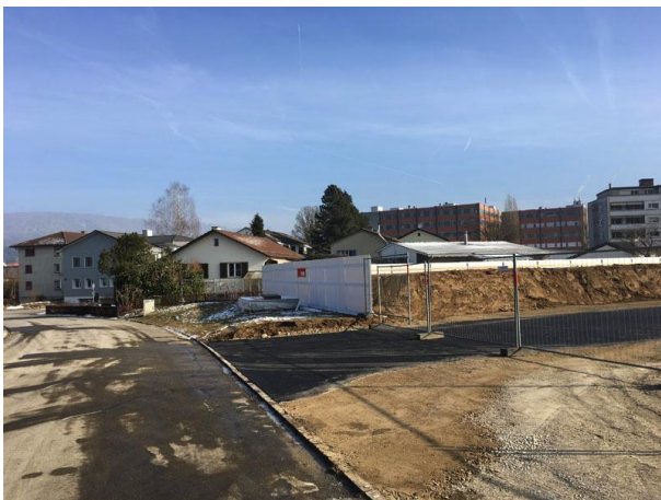
Umgebung: Baustellenzufahrt via Steinhaldenstrasse
