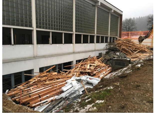
Turnhalle: sortiertes Abbruchmaterial
