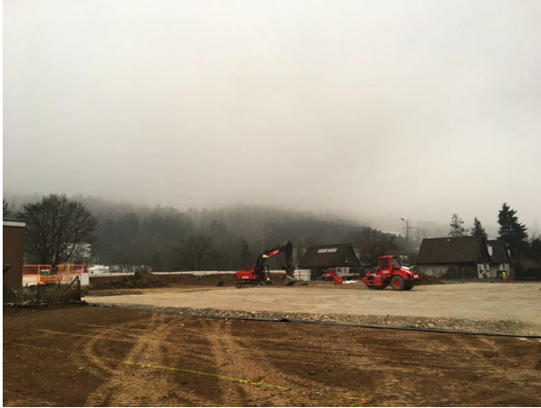
Umgebung: Schotterung Baustelleninstallationsplatz
