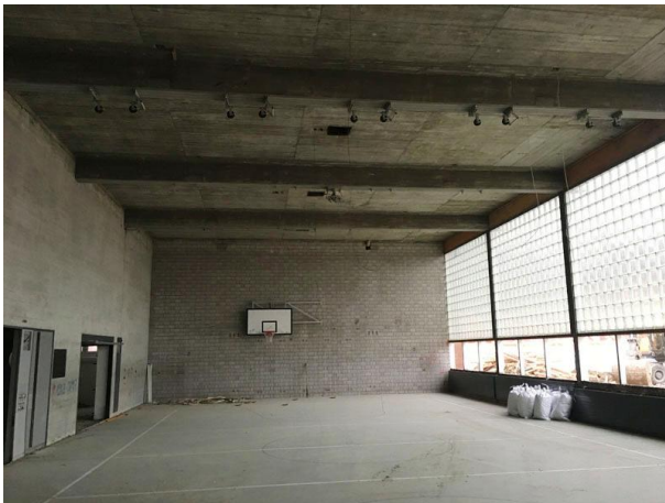
Obere Turnhalle: Zurückgebaut in Rohbauzustand
