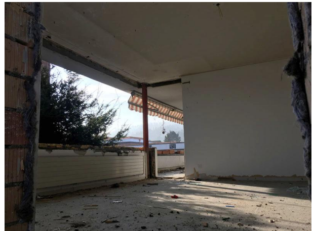
Rückbau/Abbruch: Wohnzimmer Hauswartwohnung
