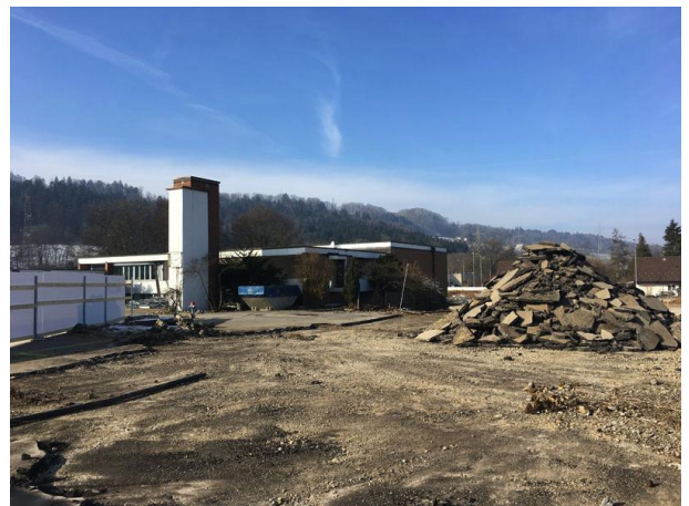
Umgebung: Abbruch alter Asphaltbelag Pausenplatz
