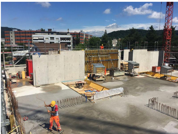
Schulhaus: Decke Erdgeschoss fertig betoniert, Wände Obergeschoss in Arbeit
