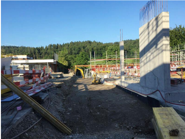
Turnhalle: Hinterfüllung Bereich Haupteingang Turnhalle
