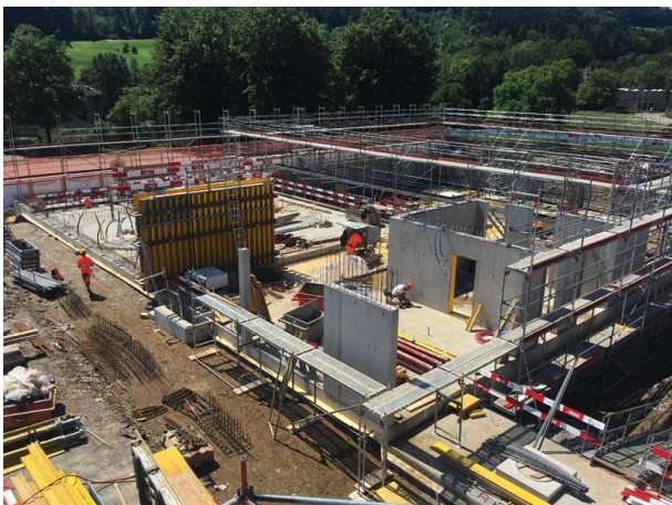
Turnhalle: Decke Untergeschoss fertig betoniert, Wände Erdgeschoss in Arbeit
