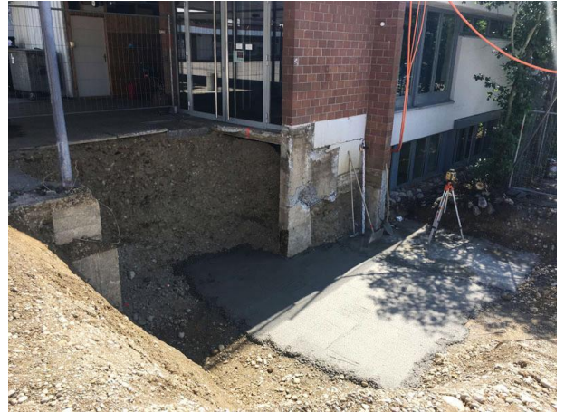
Umgebung: Abbruch/Aushub alte Treppenanlage für die Erstellung der neuen Aussentreppe zwischen dem Schulhaus Ebnet 1 und der Turnhalle Ebnet 5
