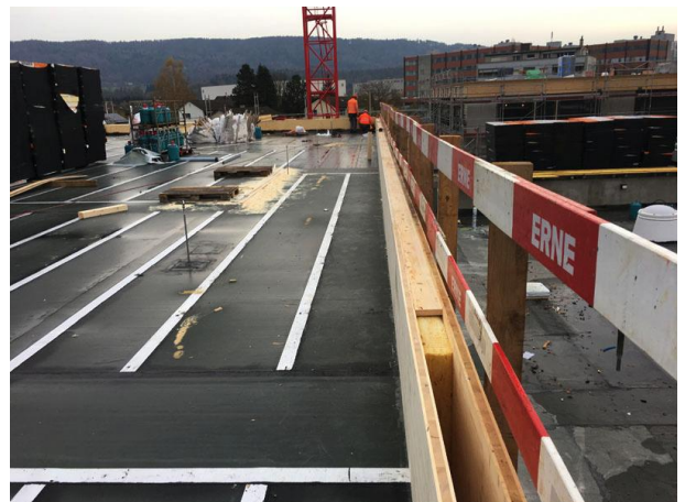
Turnhalle: Montage Dachrand aus Holz, Aufbahrung Dampfbrake
