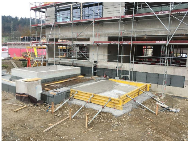
Schulhaus: betonierte Schleppplatte Bereich Schnitzersilo
