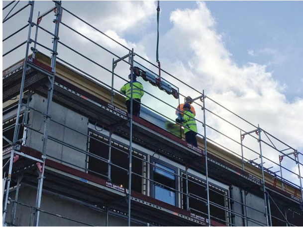
Schulhaus: Montage Gläser, Gewicht bis 320kg
