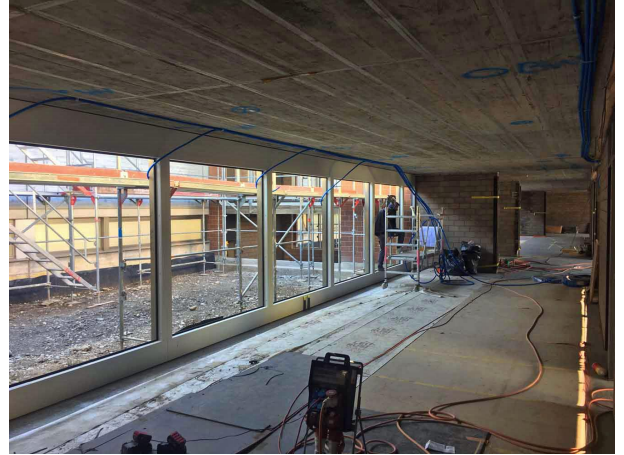
Ebnet 2, Lernlandschaft: Neue Fensterfront, Elektroinstallationen
