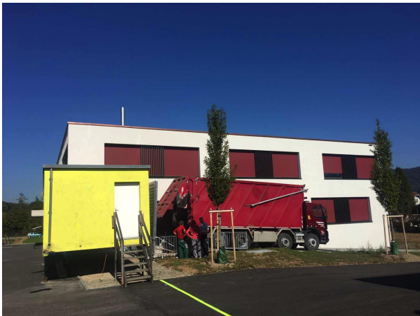
Ebnet 4, Silo: Anlieferung Holzschnitzel
