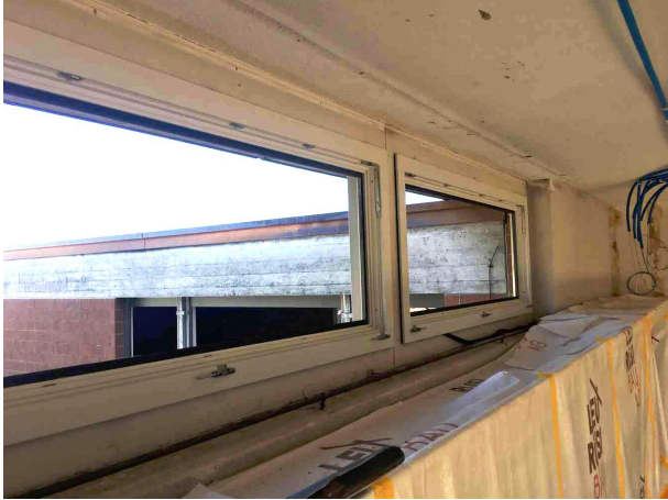
Ebnet 2, Klassenzimmer: Neue Renovationsfenster oberhalb Schrankanlage
