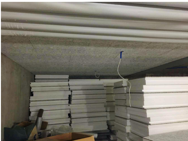
Ebnet 2, Untergeschoss: Start Deckendämmung Lagerräume
