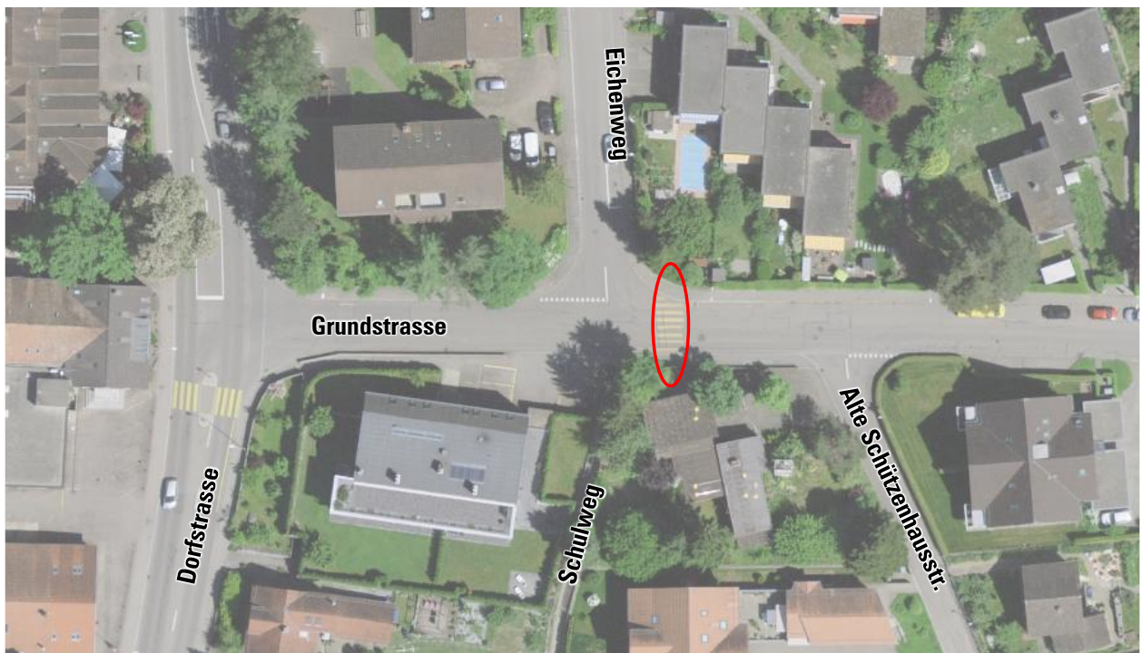
Abbildung 13: Luftbild Knoten Grundstrasse/ Eichenweg (vor Einführung T30 Zone)
