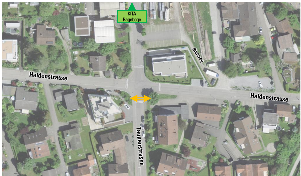
Abbildung 19: Luftbild Knoten Tannen-/Haldenstrasse (vor Markierung FGS und Belagsarbeiten)
