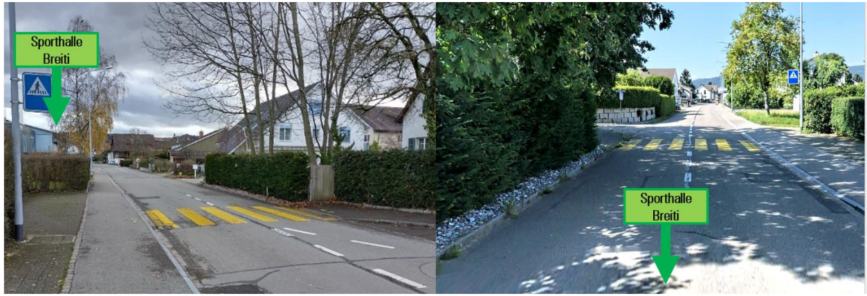
Abbildung 22: Fussgängerstreifen nördlich Sporthalle Breiti Richtung Kindergarten - Sicht von Süden her eingeschränkt
