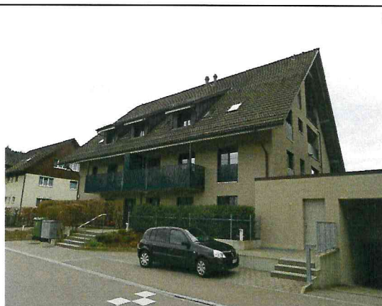
Nordostfassade mit Gebäudeeingang
